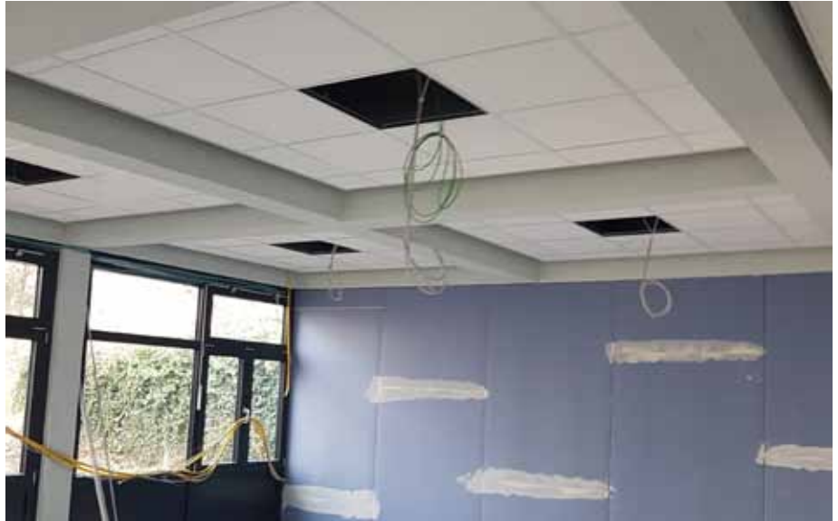
Es tut sich was im Gemeinschaftshaus. Die Arbeiten gehen planmäßig voran. Es ist zu hoffen, dass die Eröffnung - trotz Corona - wie geplant stattfinden kann.
