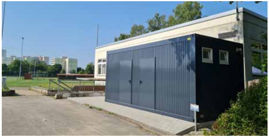
Die Toiletten- und Duschanlage am Waldheim
